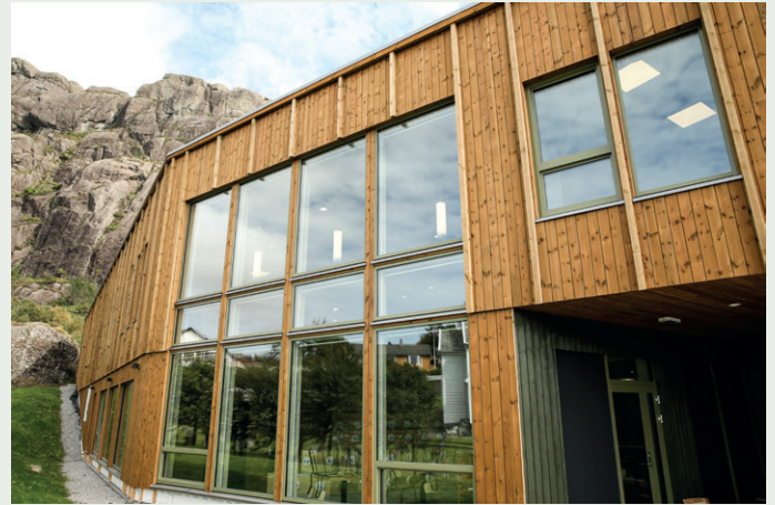
Baksiden av bygget mot nord har store vindusflater med utsikt mot Solund kyrkje.
